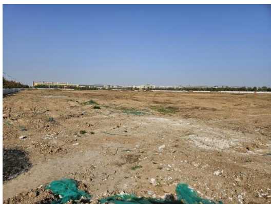
建设场地现状
